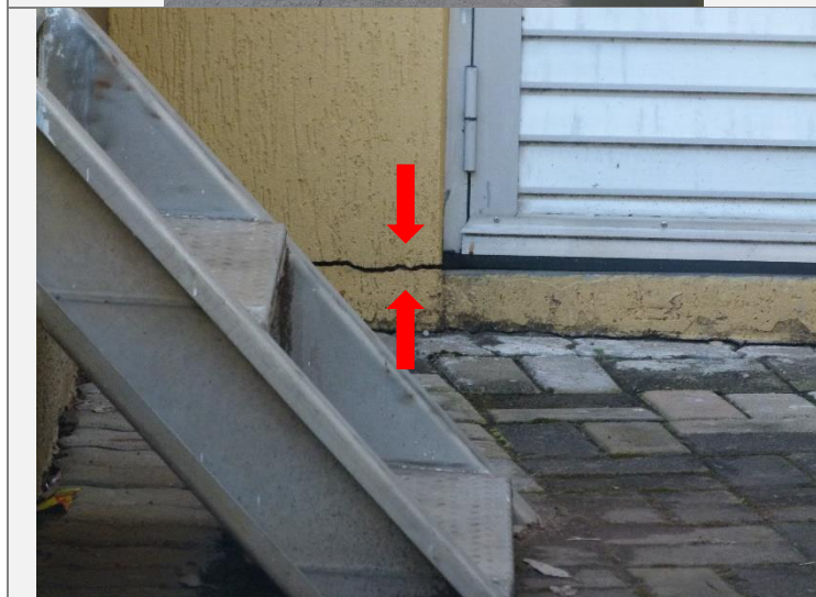
Trinca horizontal junto a soleira da porta.
