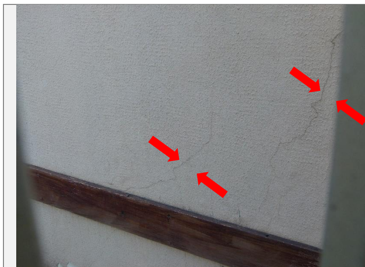
Fissuras na parede de alvenaria, fachada frontal.
